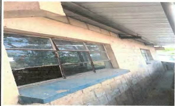
Foto 2: Se realizará instalación de balcones para el mejoramiento de ventanas del módulo 1.
