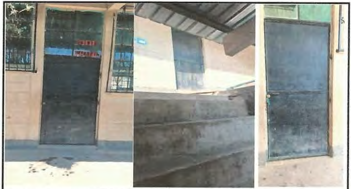
Foto 4: Se realizará mejoramiento con pintura de puertas para las aulas y dirección del centro educativo. Módulo 1 al 5.
