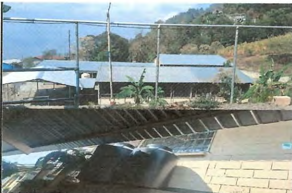
Foto 3: Se realizará instalación de canales y bajadas de agua de las aulas módulo 3
